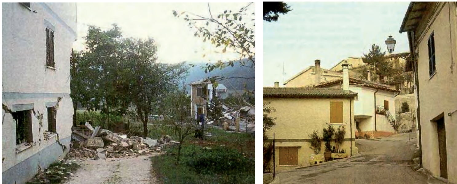
Figura 1.1-2 – Terremoto Umbria-Marche, 1997. Differenza di danneggiamento in località vicine, dovute ad effetti locali. A sinistra Cesi Bassa (IX MCS), a destra Cesi Villa (VII MCS).
