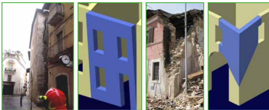
Figura 6. Esempi di meccanismi di collasso: ribaltamento integrale della facciata (sinistra); collasso dell'angolata (destra) (DPC-ReLUIS, 2011).
